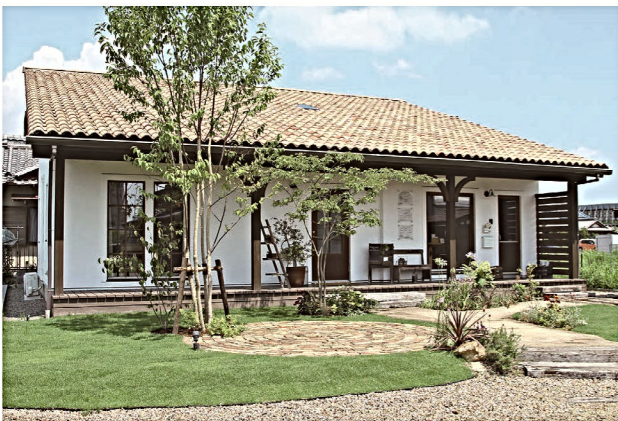
事務所兼ショールーム外観
